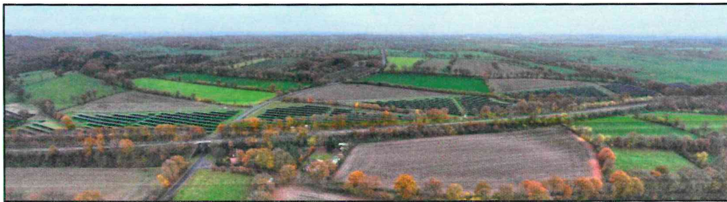
Abbildung 8: Bestandsanlage und Bahndamm von Norden her (Quelle: eigene Darstellung)
