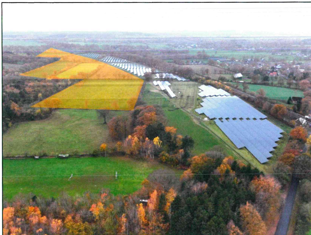
Abbildung 4: Luftbild vom östl. Rand der bestehenden PV-Anlage (aktuelles Plangebiet farblich hervorgehoben) (Quelle: eigene Darstellung)
