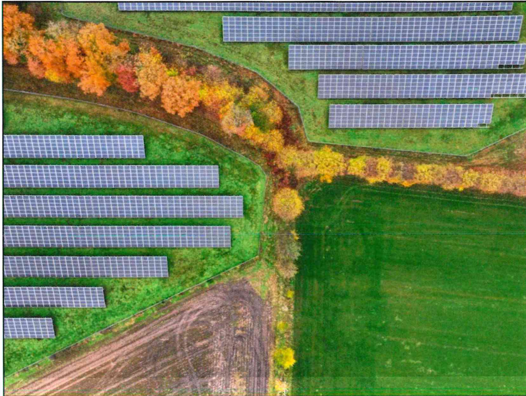
Abbildung 15: Knickstrukturen am Schnittpunkt von Plangebiet und Bestands-PV-Anlage (Quelle: eigene Darstellung)
