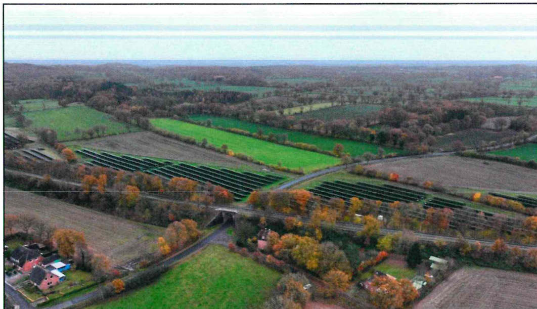
Abbildung 23: Blick von Norden über Bahndamm, Bestands-PVA, Plangebiet und offene Landschaft (Quelle: eigene Darstellung)
