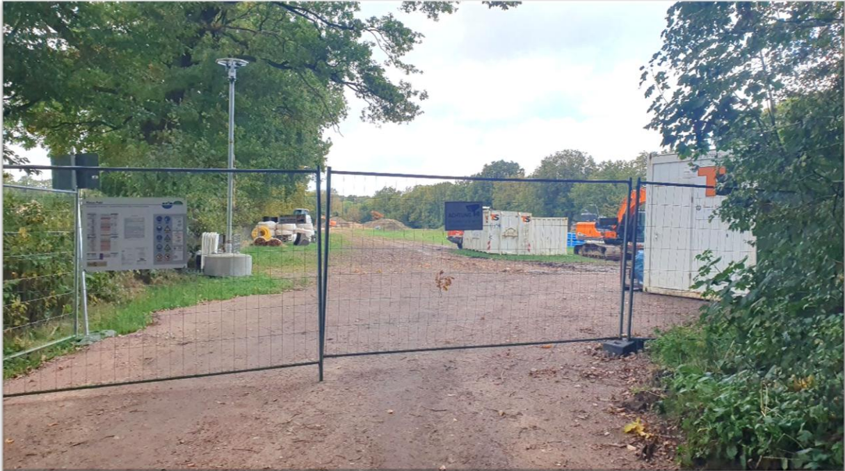
Foto 1: Blick auf das Plangebiet in nördliche Richtung mit Baustelleninfrastruktur im südlichen Bereich des Plangebietes
